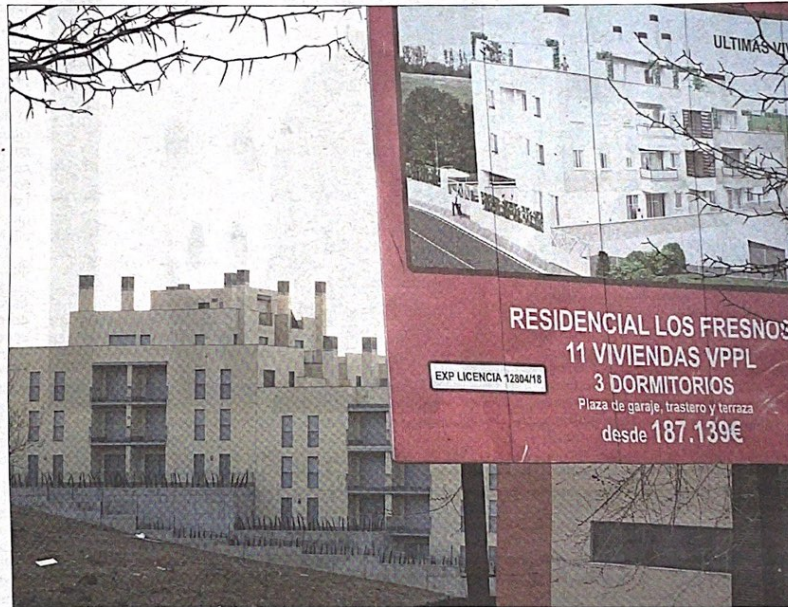
Viviendas en construcción en Colmenar Viejo (Madrid). / SANTI BURGOS
